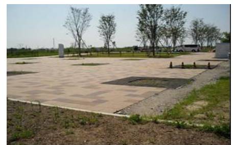
【セラックTKHの施工例】
