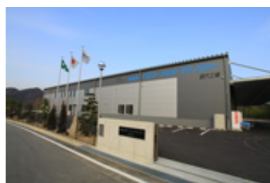
苗代工業団地第3工場
