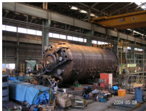
大型の攪拌槽や既設 タンクを製作工場など 現地施工が可能
