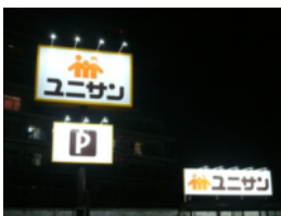
LED看板照明 LEDスクエアライト 90度拡散タイプ 合計12台設置
