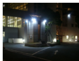
LED屋外照明 駐車場通路、搬出出口を照明 LEDスクエアライト 90度拡散タイプ
