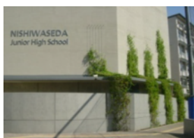
壁面緑化施工例
