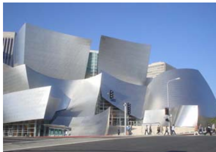
米LAのディズニー・コンサー トホールのステンレス外壁
