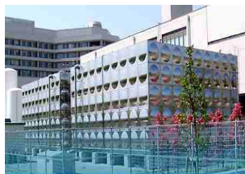
ステンレスパネルタンク(溶接型)
