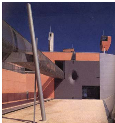
リアスアーク美術館(気仙沼市) 正面のエントランスは厚さ30cmの鋼板の一部が凹んでいる
