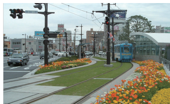
(施工例:鹿児島中央駅前市電軌道内)
