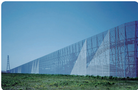
貯炭場防塵フェンス
