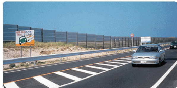
海浜道路防風・防砂フェンス
