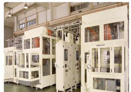
生産工程削減に寄与した クランクシャフト焼入ライン
